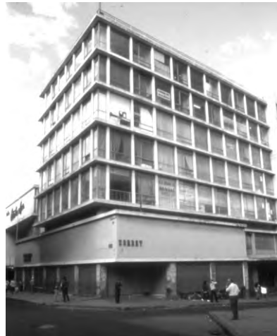
Ilustración 4: Sixto Durán-Ballén, Edificio Bolívar , construido a fines de 1950, Quito. Archivo personal del arquitecto Julio Matovelle, Quito.
